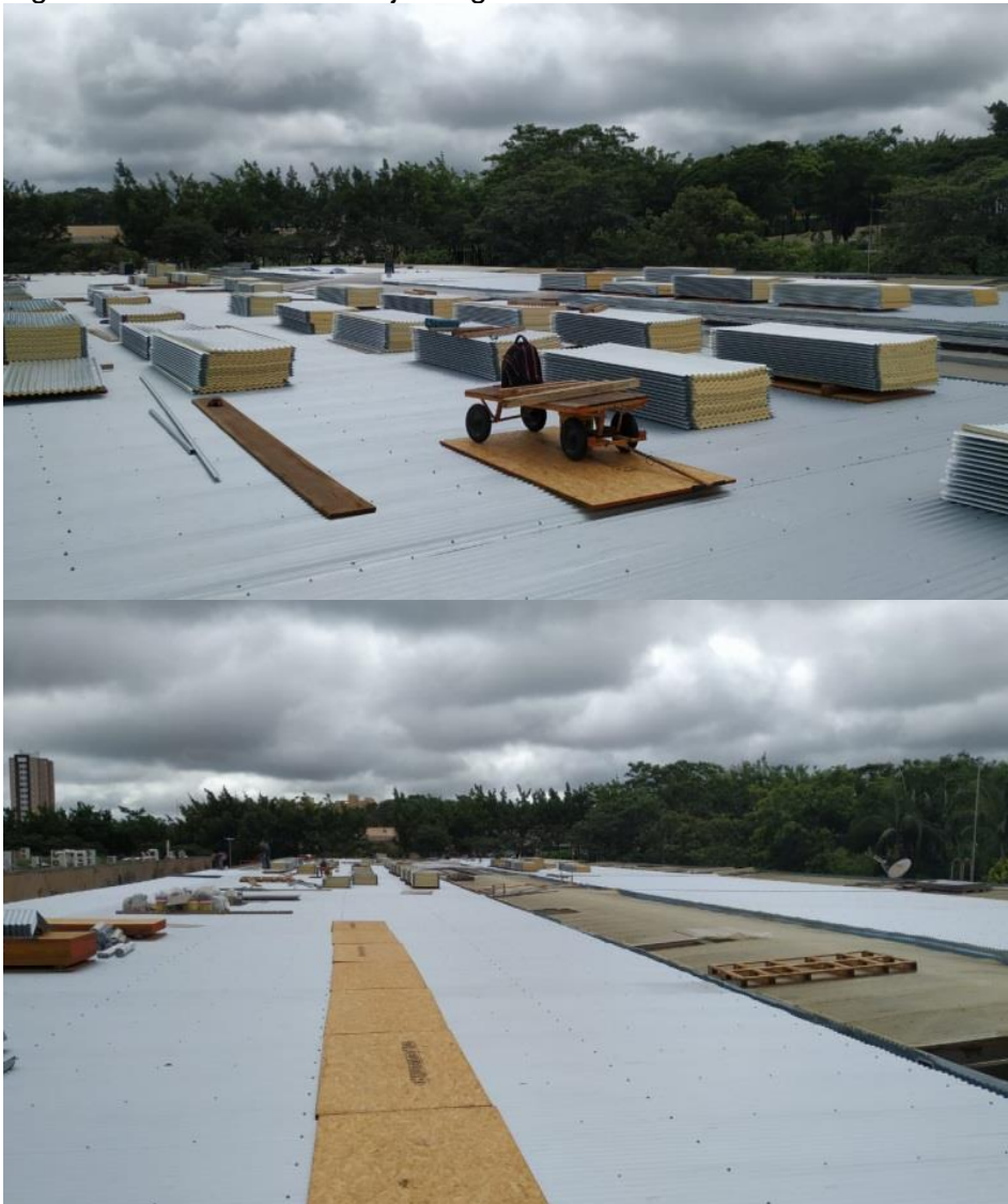
Figura 32 - Cobertura da Laje Alagada: Cobertura nos Blocos F e G
