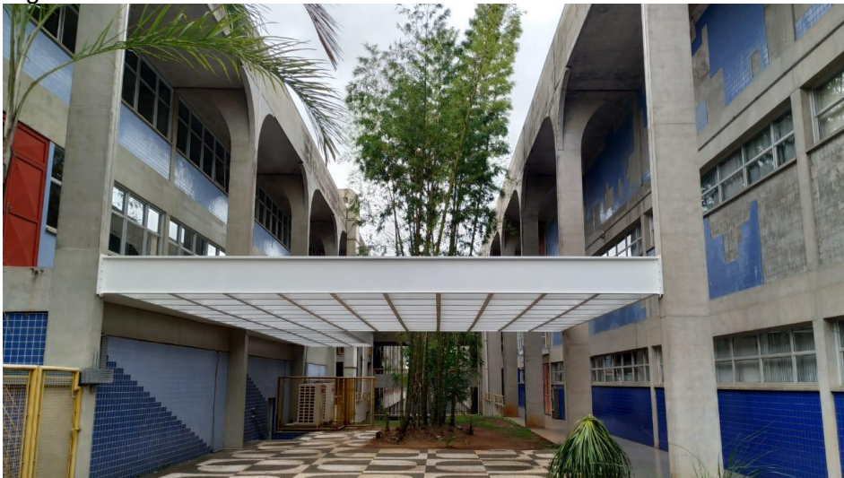
Figura 31 - Cobertura no Bloco JK
